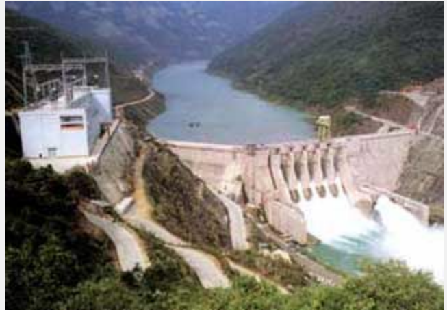
▲ Dachaoshan-demningen (1350 MW) i Mekong elven.
